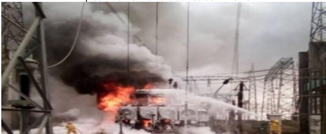
Figura No 2 Explosión en la Planta eléctrica de El Furrial
